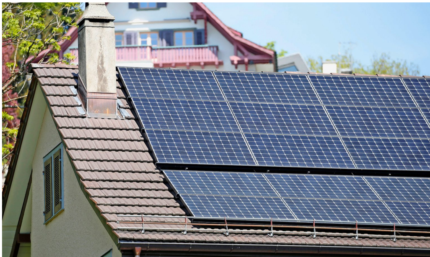
Der Bau von Solaranlagen auf den Hausdächern in Meilen geht der SVP zu langsam voran. Symbolfoto: Moritz Hager
